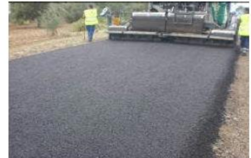
Foto 10. Extendido mezcla templada cerrada
