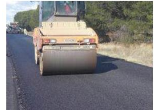
Foto 10. Compactado mezcla templada
